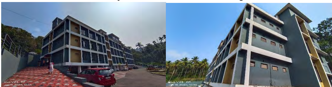
Fig 18.1 Mini Civil Station at Vellarikkund
